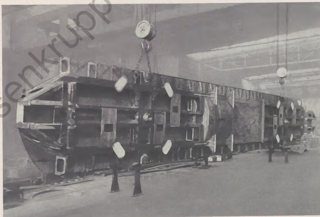
Brückenträger einer dieselelektrischen Lokomotive (TT 12, Ghana-Lok), von unten gesehen.
