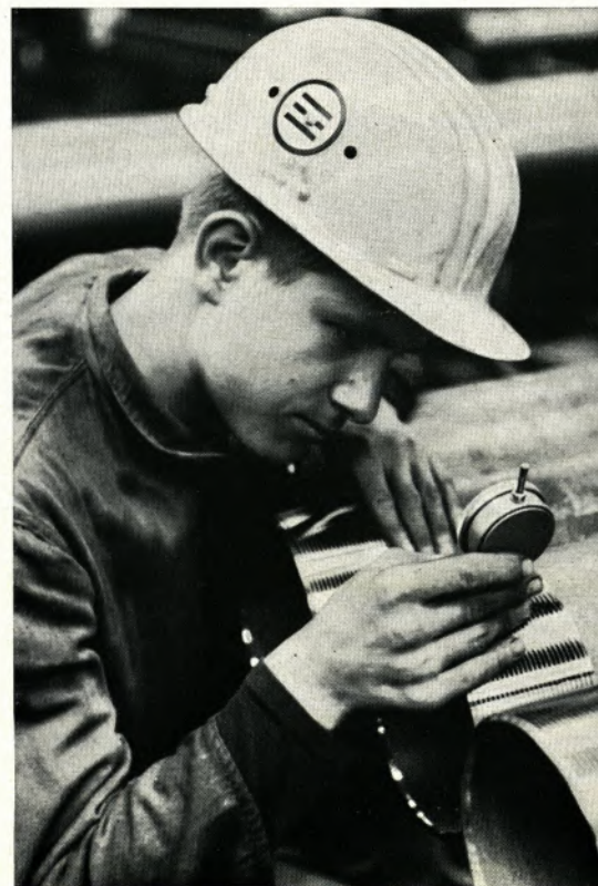
Gewindeschneider Ernst Alex prüft in der Bohrrohdreherei des Werkes Poensgen mit seinem Meßgerät das Gewinde eines Ölfeldrohres, das er gerade geschnitten hat
