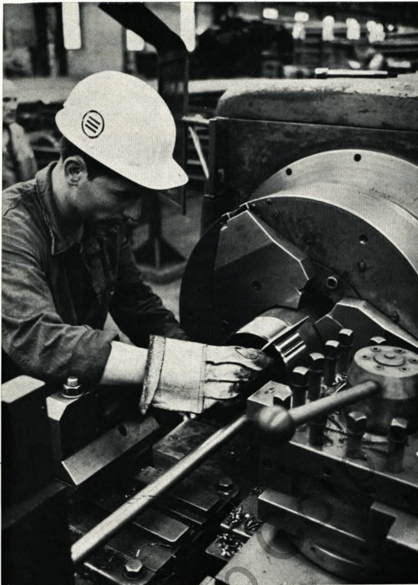
Gewindeschneider Ernst Alex prüft in der Bohrrohdreherei des Werkes Poensgen mit seinem Meßgerät das Gewinde eines Ölfeldrohres, das er gerade geschnitten hat
