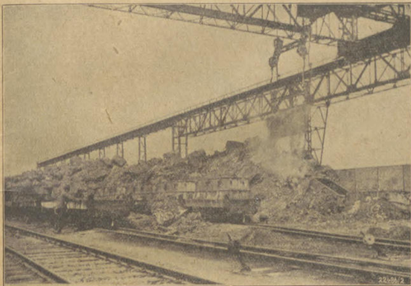
Die beim Erkalten zu Blöcken erstarrte Thomaschlacke wird auf den Schlackenplatz gebracht
