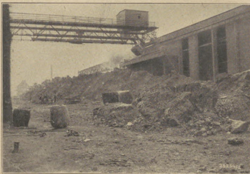
Die Schlacken werden mittels des Krans in die Mühle gekippt
