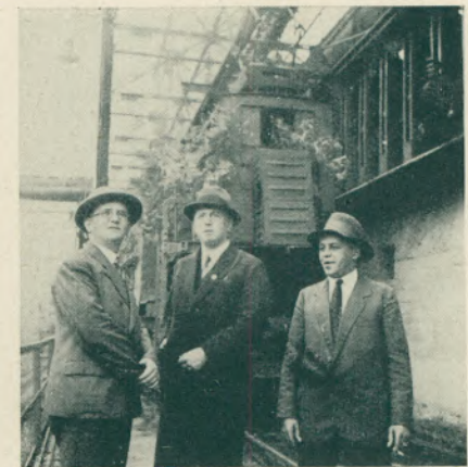
Die Betriebsleitung ist zufrieden: alles klappt!
