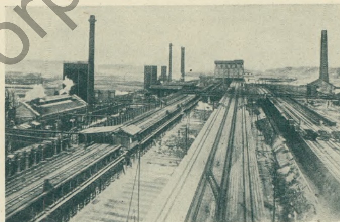
Koßerei der Yawata-Eisenwerke.
