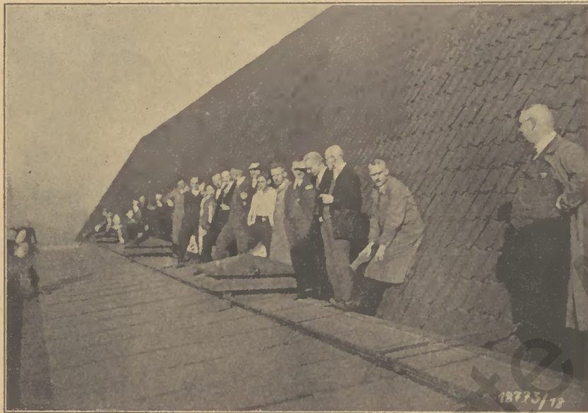
Auf dem Dach der Dortmunder Union in Erwartung des „Zeppelin“
