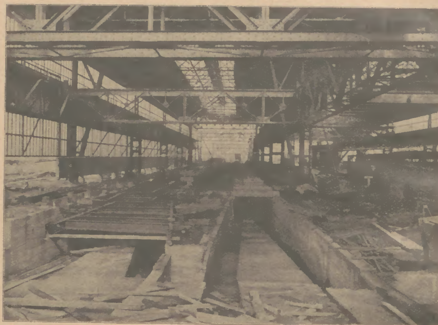
Abb. 1: Halle Walzwerk VIII im Bau
