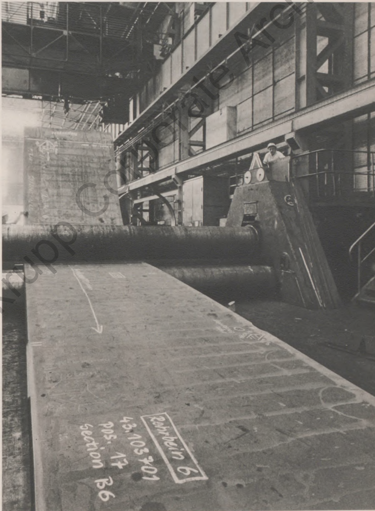
▼ Die Verformung der Bleche auf der Vierwalzen-Blechbiegemaschine. Robert Stanek und Adolf Bekel beim ersten Anbiegen einer zwei Meter breiten und zehn Meter langen Tafel, die mit dem Hallenkran durch die Walze gezogen wird
