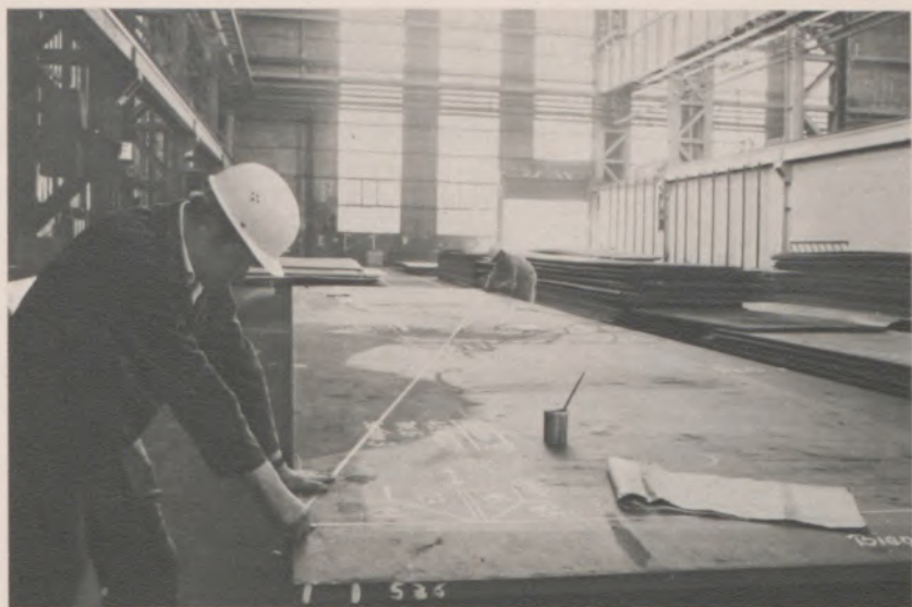
◀ Die Fertigung der Bohrinsel-Beine im Werk Phoenix beginnt mit dem Anzeichnen des Grobbleches. Herbert Zengerling und Wolfgang Pollmann kontrollieren durch Messen der Diagonalen die Maßhaltigkeit der Bleche
