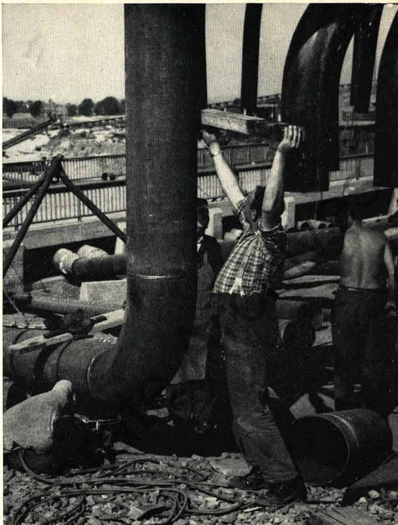
Die Montagekolonne des VRB hatte 23 Monate lang beim Aufbau der Öl-Raffinerie in Godorf schwere Arbeit zu leisten. Einen Eindruck davon vermittelt dieses Foto
