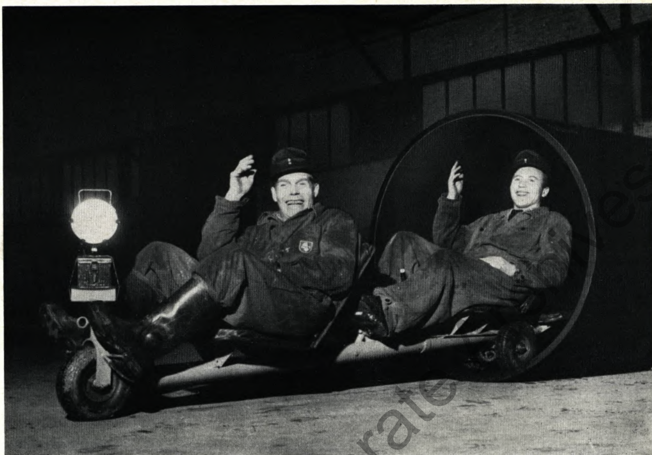
Die Bodensee-Trinkwasserleitung, an der Phoenix-Rheinrohr und der Vereinigte Rohrleitungsbau beteiligt sind, steht vor der Vollendung. Diese beiden „gucken hier beruflich in die Röhre“, nämlich bei Prüffahrten durch diese Leitung
