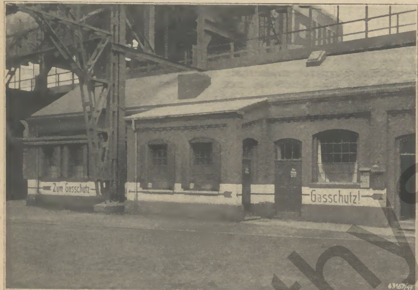
Abb. 23: Gebäude der Gaschutzzentrale
