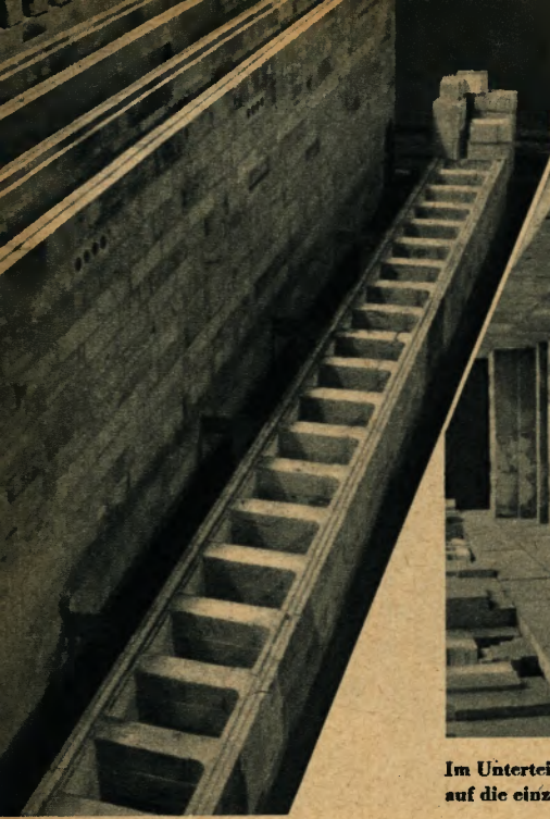
Bild einer Heizwand im Aufbau. Deutlich zu erkennen sind die einzelnen Heizzüge, in denen später das Heizgas verbrennt. Zwischen zwei Heizwände wird die Kohle eingebracht.
