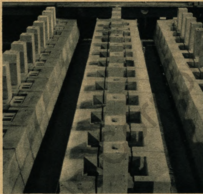
Aussicht auf die Starkgasdüsen-Steine und die Luftdurchtritte in Höhe der Ofensohlen.
