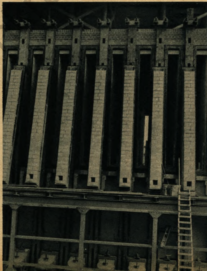
Blick auf die fertig gemauerten Ofenkammern, Ofentüren und im Unterteil die Abgasventile.
