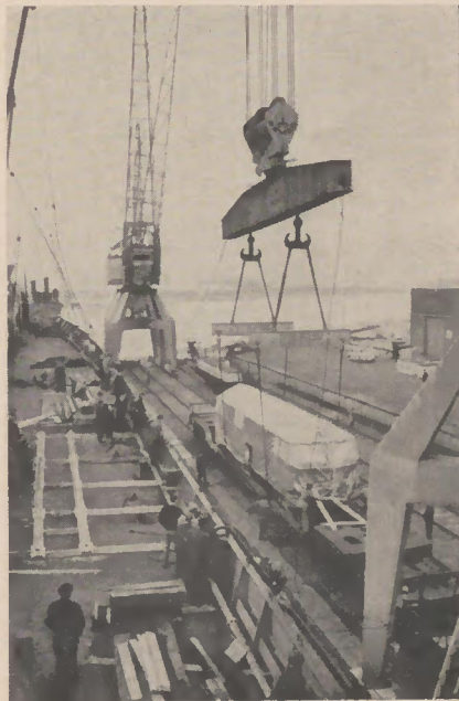
Die dritte Lok wird am Kran festgemacht.
