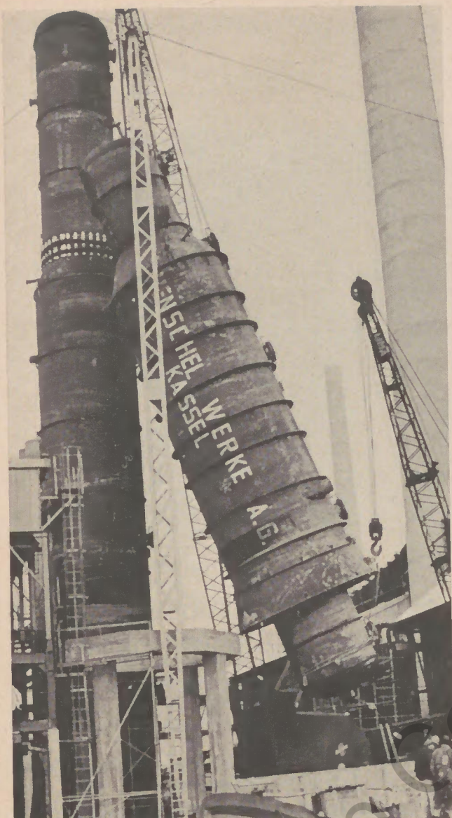
Riesige Henschel-Großbehälter, die von Kassel auf dem Wasserwege nach Dänemark geschafft worden waren, werden auf dem Gelände einer dänischen Ölraffinerie montiert.
