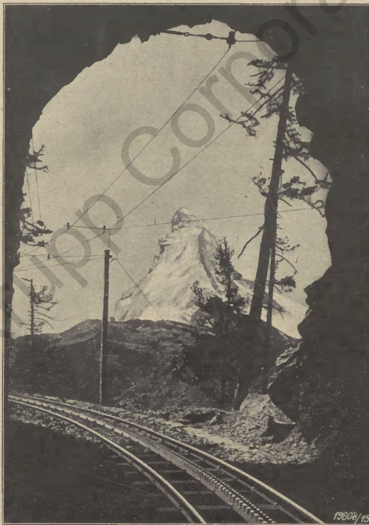
Durchblick vom Gornegratbahn-Tunnel auf das Matterhorn Im Vordergrund Zahnstangenbahn System „Abt“ der Dortmunder Union
