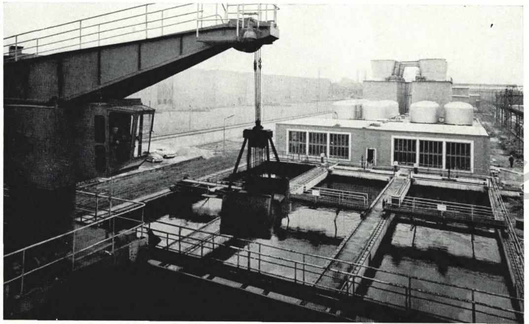
Die Klär-, Filter- und Kühlanlage des Warmbandwerkes. Der Komplex mit einer Länge von 300 Meter ist im Sommer 1961 fertiggestellt worden. Der Kran dient zum Austrag des Walzsinters und Klärschlammes aus den Becken in einen hochliegenden Abtropfbunker sowie zur Verladung in Waggons oder Lastwagen
