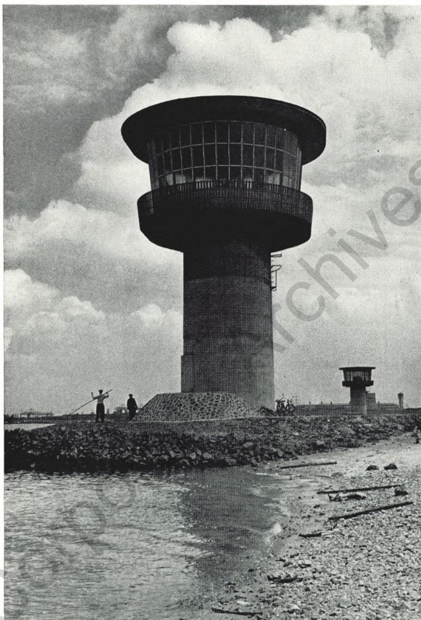
Die markanten Türme am Rhein sind die Frischwasser-Quellen der Hütte. Sie sind Eigentum der Thyssen'schen Gas- und Wasserwerke. Im Hintergrund ist der Wasserturm des SM-Stahlwerkes II zu erkennen, der zur Notversorgung der Schmelzöfen dient
