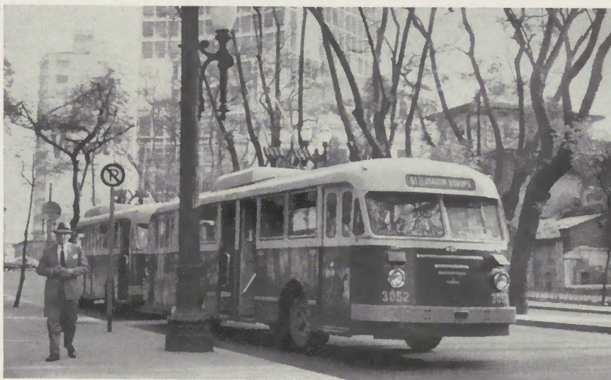
Selbsttragender Obus Typ UH III/s in São Paulo, Gemeinschafts-Konstruktion Henschel/Waggonfabrik Uerdingen, Fassungsvermögen 100 Personen
