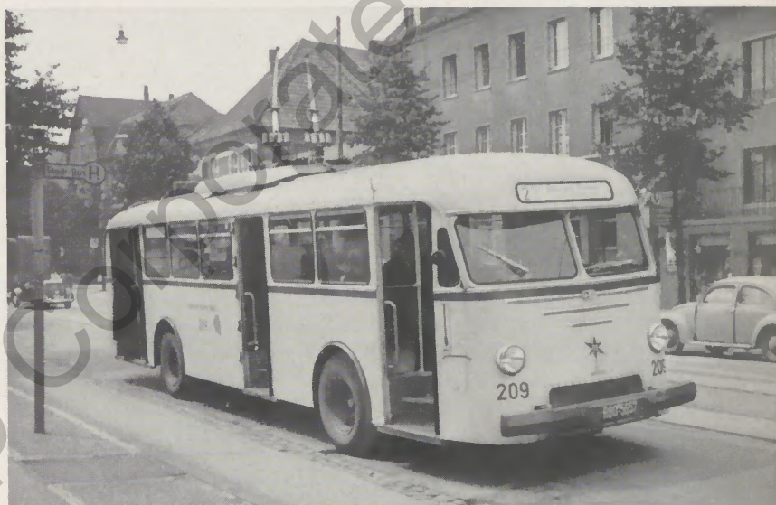
Henschel Zweiachs-Obus Typ 562 D der Stadtwerke Münster, Baujahr 1954, Fassungsvermögen 100 Personen
