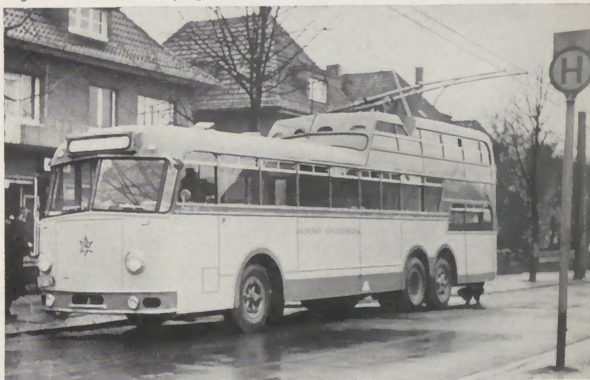
1 1/2-Deck-Obus mit Henschel-Fahrgestell Typ 562 E der Aachener Straßenbahn, Fassungsvermögen bis zu 150 Personen (Originalfoto Gebr. Ludwig, Essen)
