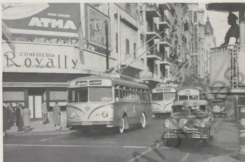
Henschel-Zweiachs-Obus Typ HS 90 E in Buenos Aires. Ausführung, wie vom argentinischen Transportministerium vorgeschrieben, mit einem Fassungsvermögen von 72 Personen
