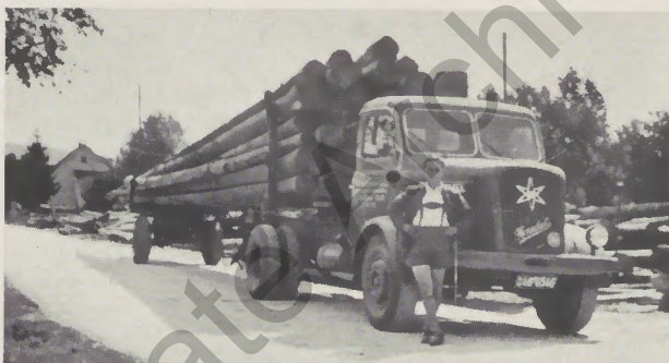
HS 120 als Langholz-Transportwagen m. Drehkranz u. Einachs-Nachläufer
