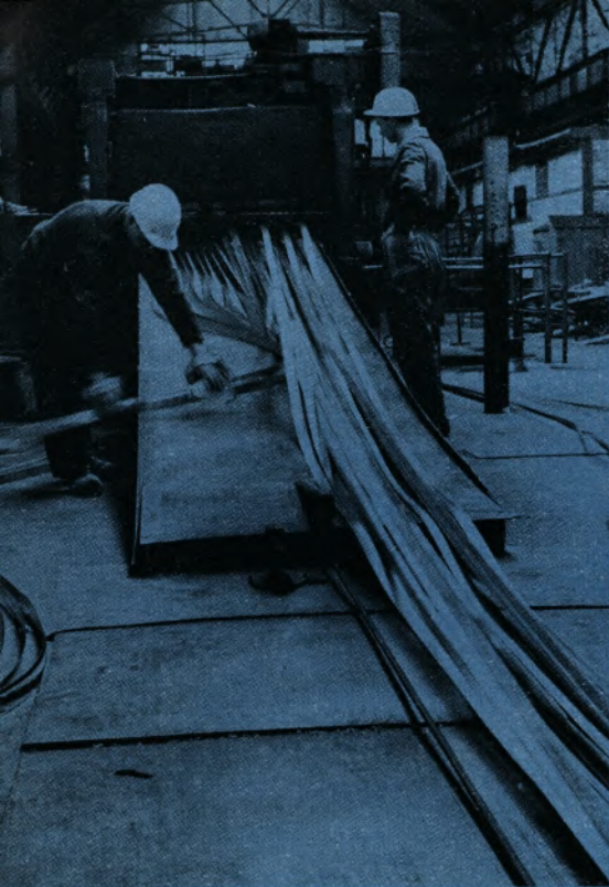
Langen Schlangen gleicht das Bandeisens, das in der Verzinkerei nach dem Trockenverfahren verzinkt wird. E. Jungbluth und K. Wiebach beim „Umlegen“ des Bandeisens
