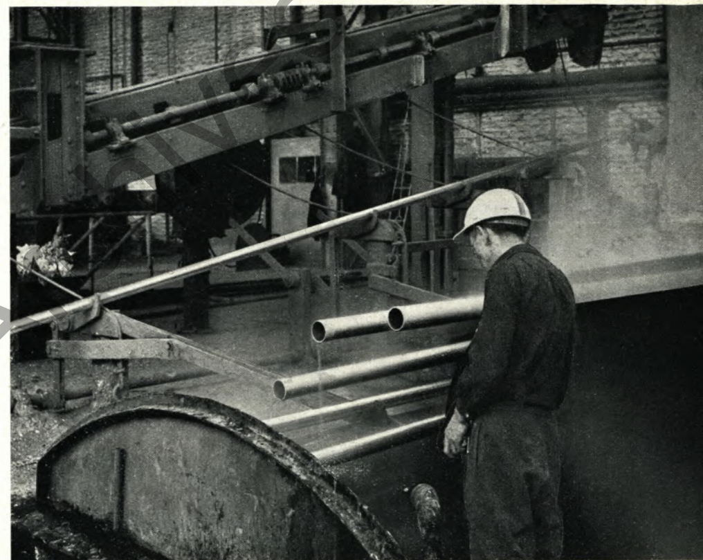
Nach dem Verzinken werden die Rohre im Wasserbad abgekühlt
