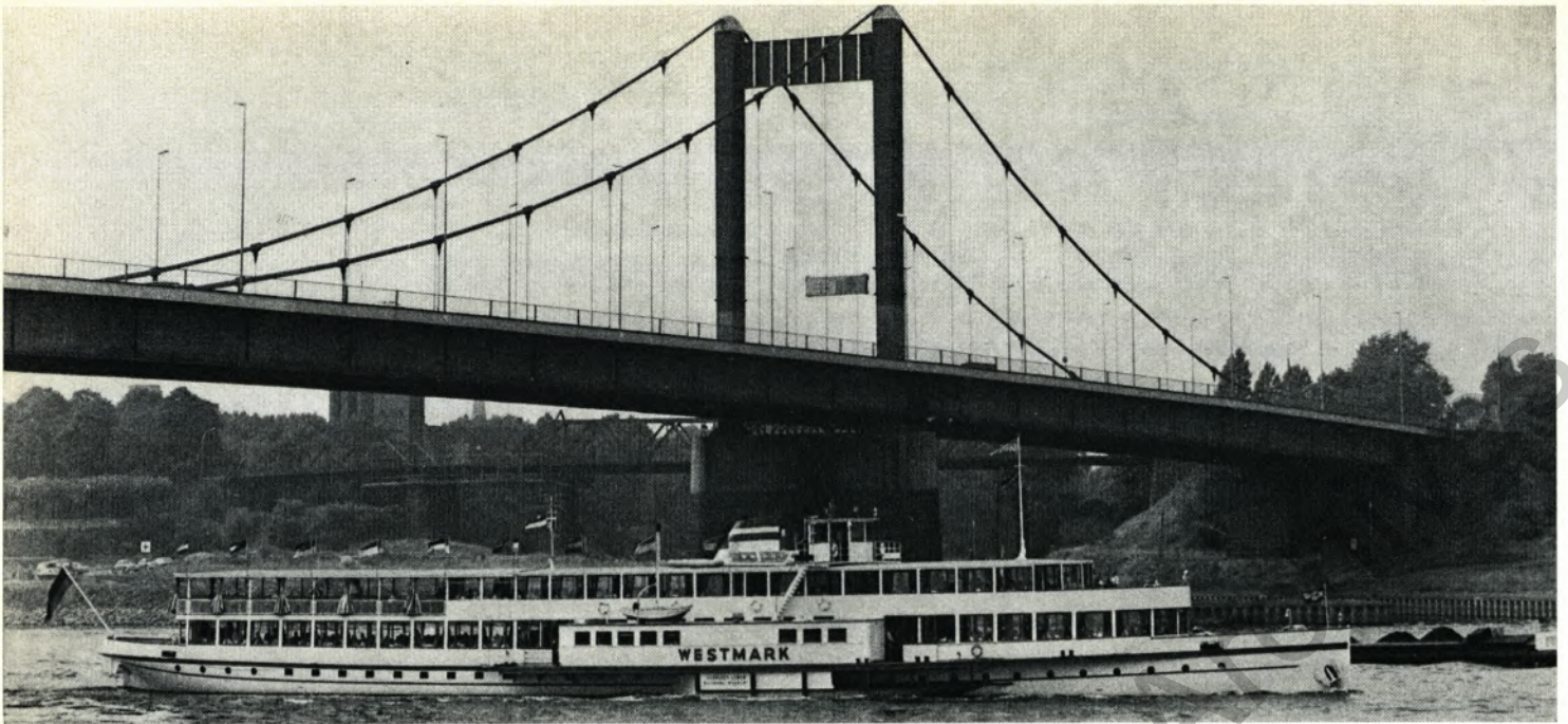
Die „Westmark“ fährt unter der Ruhrorter Brücke hindurch zur Anlegestelle.
