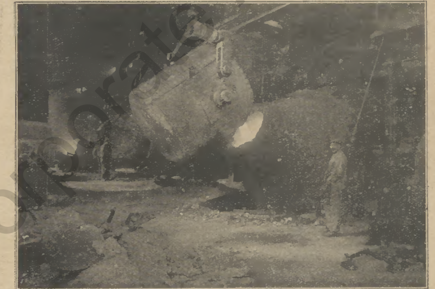
Einleeren von Roheisen in den Converter.
