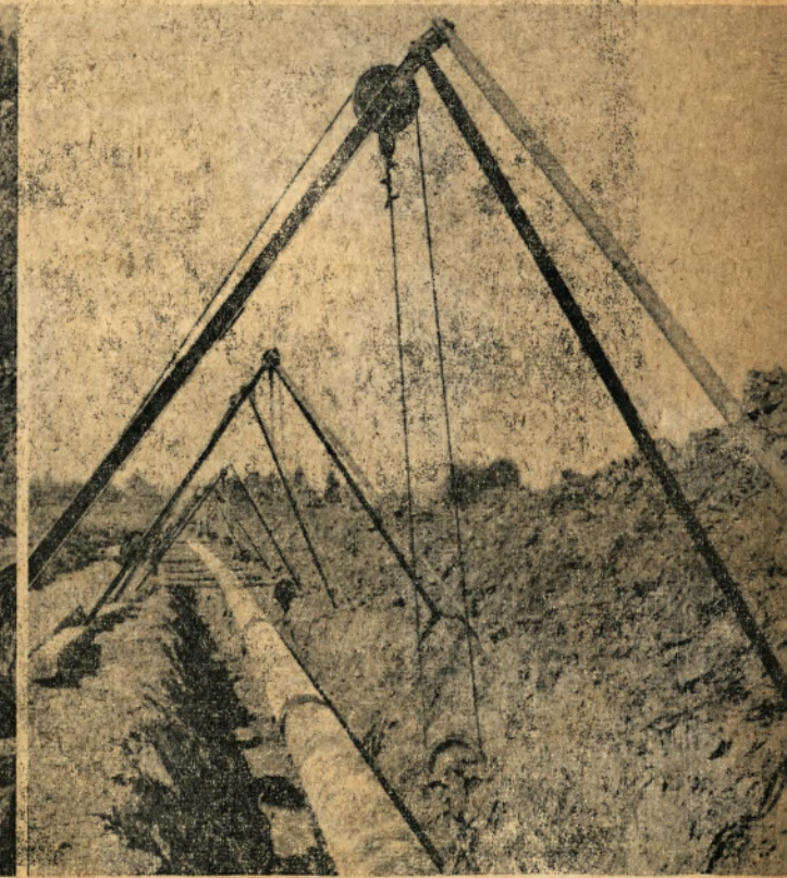
Ein verschweißter Rohrstrang (oben links) der NW. 700 wird abgesenkt. Es handelt sich um eine Reinwasserleitung aus unseren ZM-Rohren für die Wasserversorgung der Stadt Bremen. — Unten links: Die Zementmörtel-Isolierung an einer Rundnäh wird vervollständigt. — Daneben: Fertigschweißen der Verbindungsstellen an ZM-Rohren für die Ries-Wasserleitung. — Unten rechts: Der fertig verschweißte Rohrstrang der Ries-Wasserleitung kurz vor dem Absenken in den Rohrgraben. Man erkennt die Dehnungsfähigkeit der ZM-Rohre. — Oben rechts: Stoßstellen bei unseren ZM-Rohren werden verschweißt.
