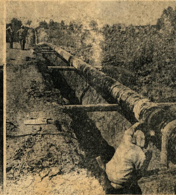
Ein verschweißter Rohrstrang (oben links) der NW. 700 wird abgesenkt. Es handelt sich um eine Reinwasserleitung aus unseren ZM-Rohren für die Wasserversorgung der Stadt Bremen. — Unten links: Die Zementmörtel-Isolierung an einer Rundnäh wird vervollständigt. — Daneben: Fertigschweißen der Verbindungsstellen an ZM-Rohren für die Ries-Wasserleitung. — Unten rechts: Der fertig verschweißte Rohrstrang der Ries-Wasserleitung kurz vor dem Absenken in den Rohrgraben. Man erkennt die Dehnungsfähigkeit der ZM-Rohre. — Oben rechts: Stoßstellen bei unseren ZM-Rohren werden verschweißt.
