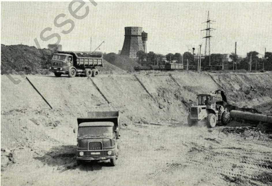
3 u. 4: Mit den Bauarbeiten für die neue Schutt-reparation am Rheinufer des Hafens Schwelgern wurde Ende Mai begonnen. Unsere Aufnahmen zeigen die Baugrube für den Tiefbunker aus Stahlbeton sowie die umfangreichen Erdbewegungen zur Herstellung des erforderlichen Lagerplatzes für 40 000 t.
