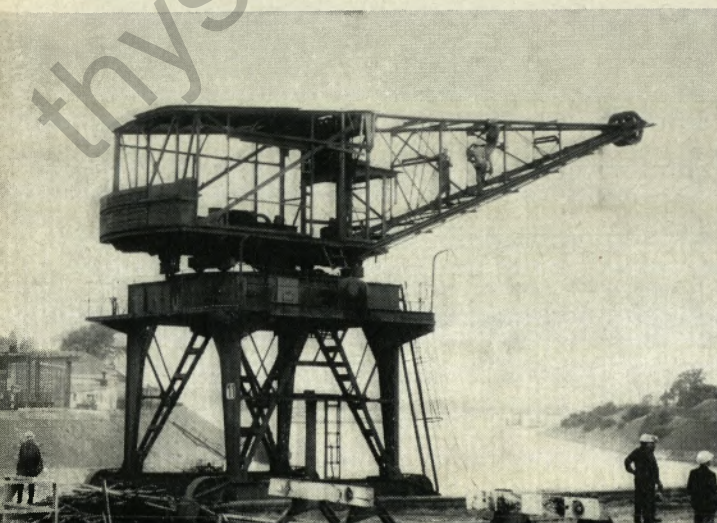
Abbruch des Kranes 11.
