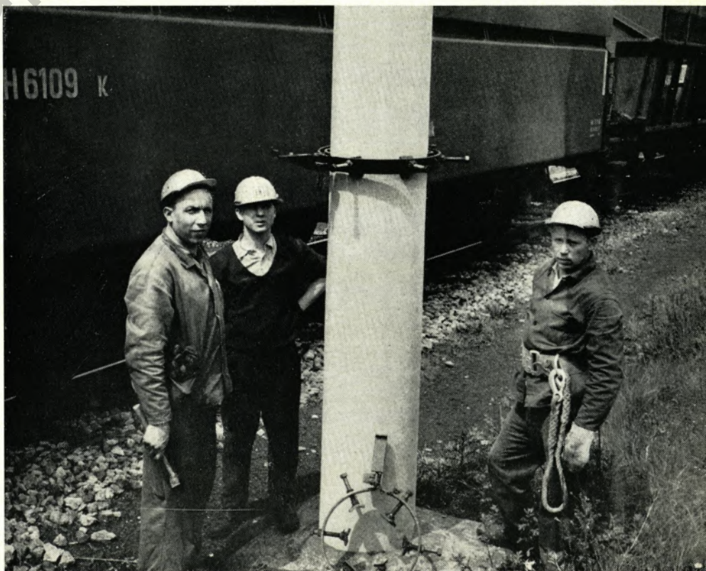
Verwendung der auf verschiedene Mastdurchmes- ser einstellbaren Steigeisen im Betrieb unserer Fahrleitungsmeisterei.
