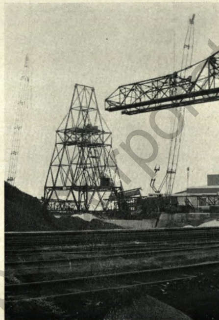
Die abgetrennten Konstruktionsteile werden mit Autokranen demontiert und verladen.
