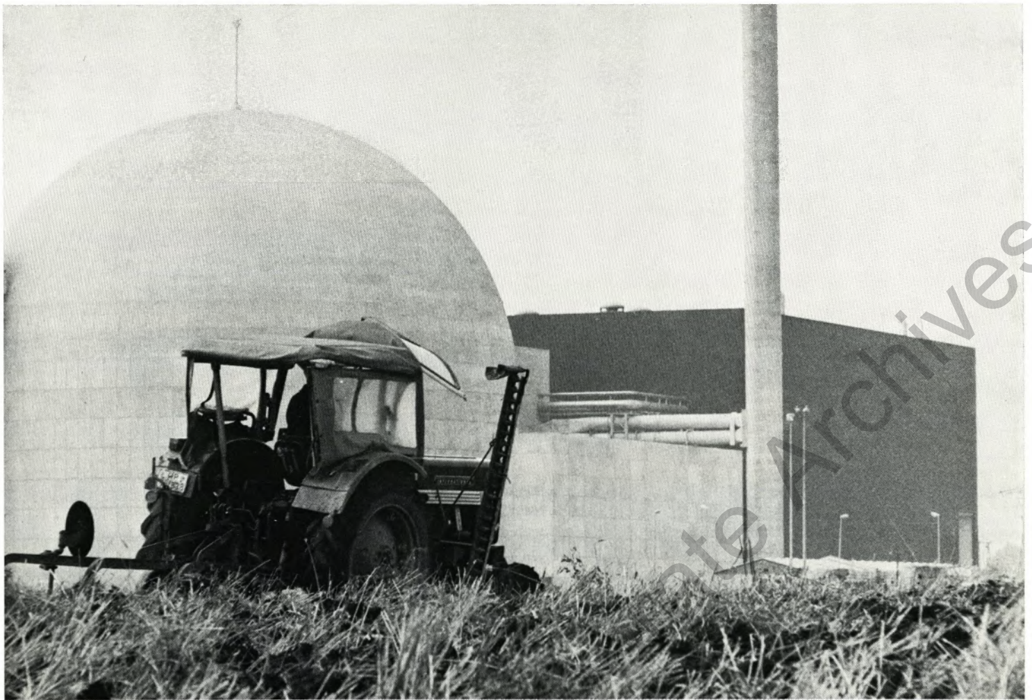
Für die Landwirte um Biblis gehört die Silhouette des Kraftwerkes längst zum gewohnten Anblick. Links im Bild die Betonabschirmung um die kugelförmige Sicherheitshülle des Reaktorgebäudes.
