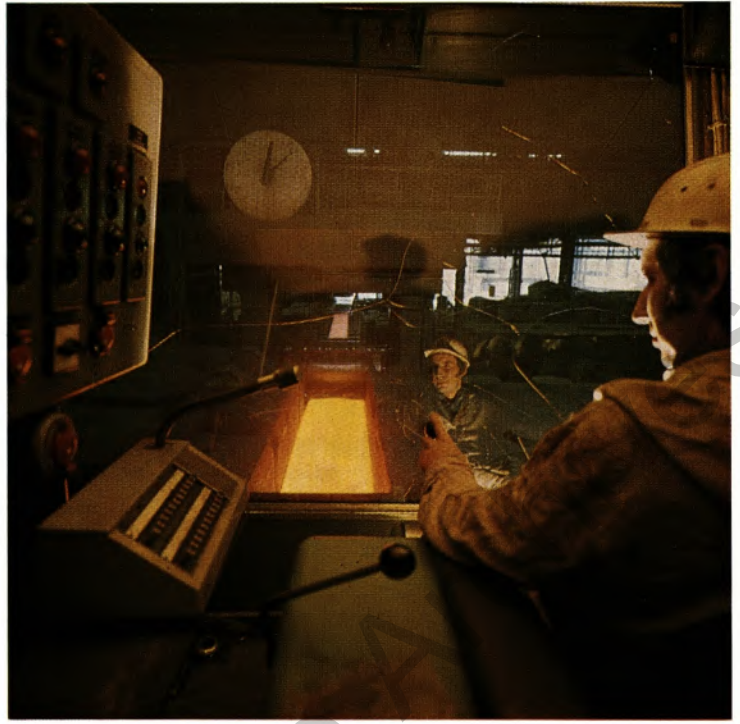
Blick von der Steuerbühne auf das Brammenwalzgerüst mit den Hilfseinrichtungen.
