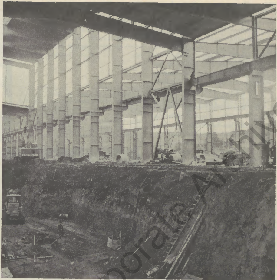
▲ Baugrube für die Maschinenfundamente
