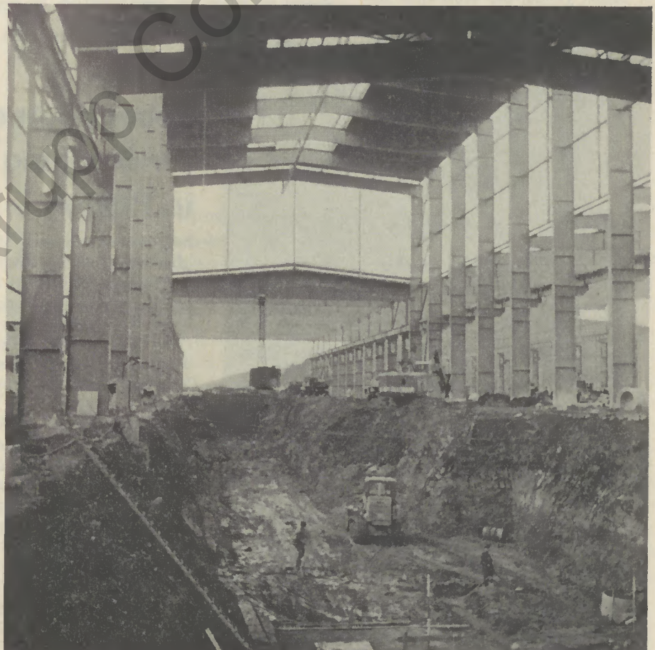
▼ Ausschachtungsarbeiten für die Maschinenfundamente
