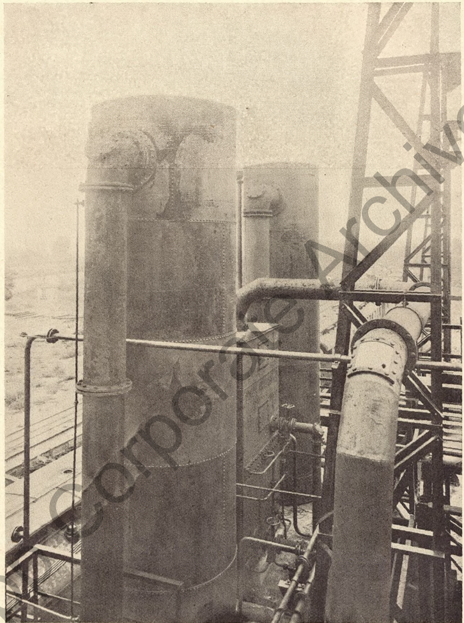
Abb. 18. Generatoranlage zur Gewinnung von Tieftemperatur-Teer (Urteer).
