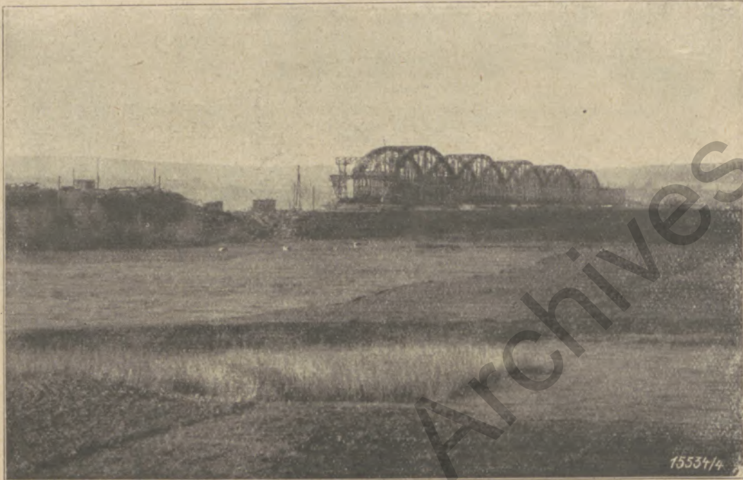
Der Stand der Abbrucharbeiten am 27. Oktober 1928
