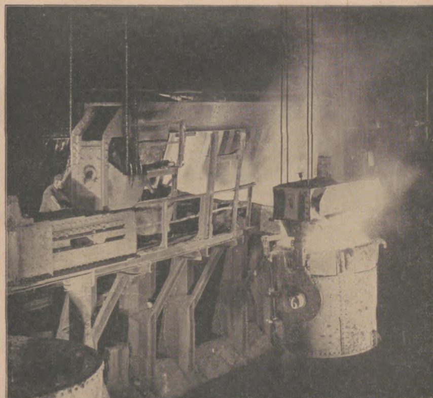
Abstich eines Siemens-Martin-Ofens — die Geburtsstätte unserer hochwertigen Stähle
