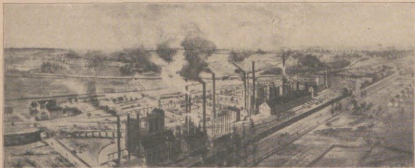
Das Hördter Hochofenwerk nach einem Gemälde aus den achtziger Jahren
