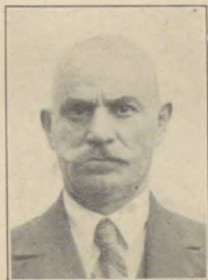
Kabelarbeiter Achim Meszaros, Elektrische Zentralen Thjssenhütte am 12. 7. 1910
