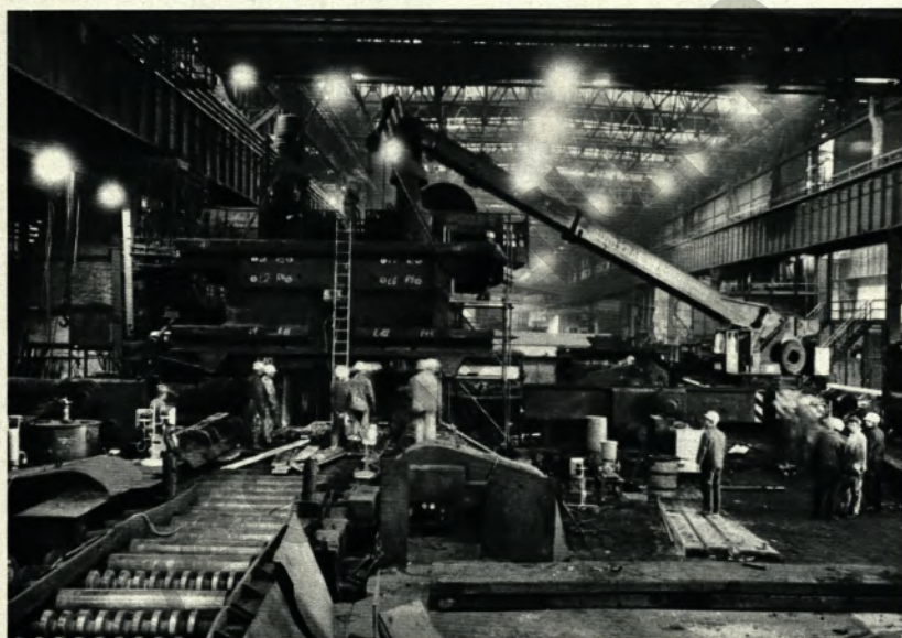
▲ Blick in die Praxis der Arbeit mit Netzplänen: Während des Wochenendes wird das Vertikalgerüst der Brammenstraße im Breitbandwalzwerk generalüberholt
