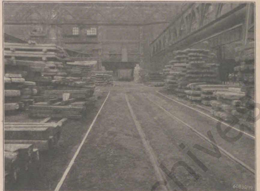
Bild 8: Begrenzung der Eisenbahnprofile durch eingelassene Schienen
