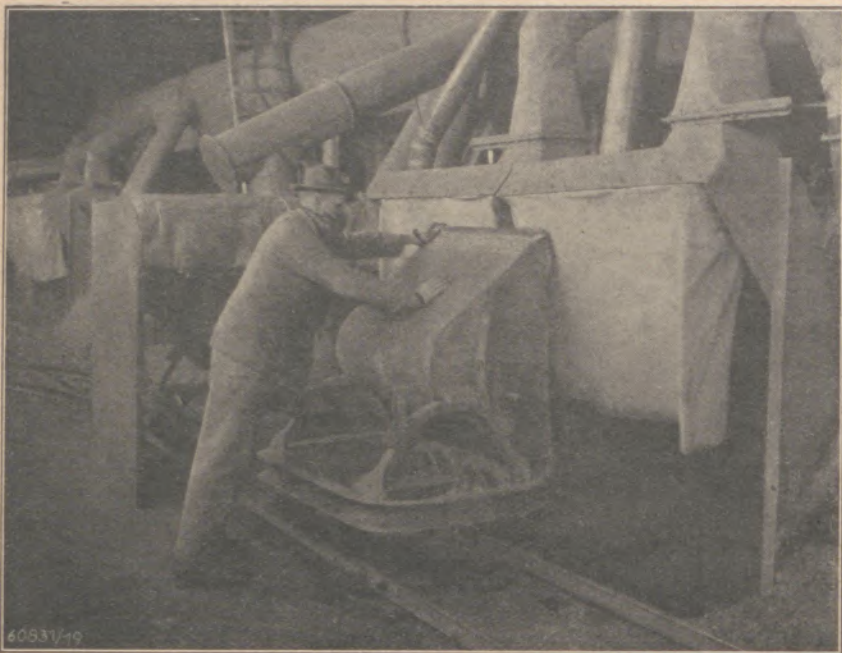
Bild 12: Bekämpfung der Staubbelästigung durch vorgebundene Lächer und Abstellung des geleerten Wagens unter einer Kammer, beiderseits in Verbindung mit einer kräftigen Ventilation
