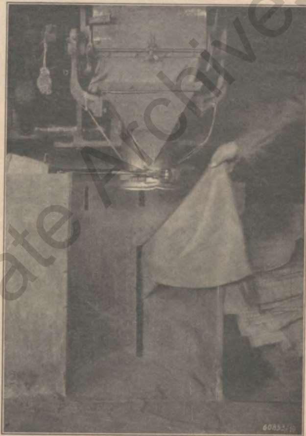
Bild 14: Die Wirkung der Abjaugung wird am besten durch den vorgehaltenen Sack veranschaulicht
