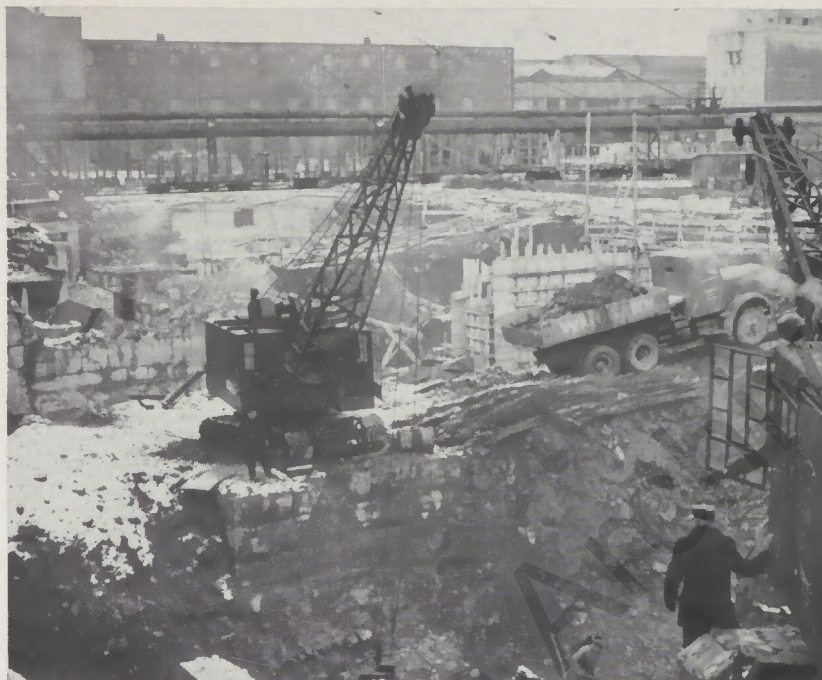
Januar 1955: Umfangreiche Ausschachtungen vor dem Baubeginn
