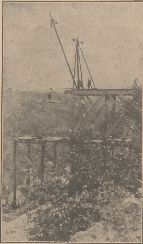
Abb. 7: Wiederaufbau der Brücke in Durcal — Stand vom 24. Mai 1923.
