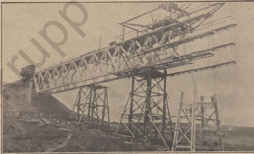
Abb. 4: Abbruch des zweiten eisernen Pfeilers — Stand v. 25. 5. 1923.
