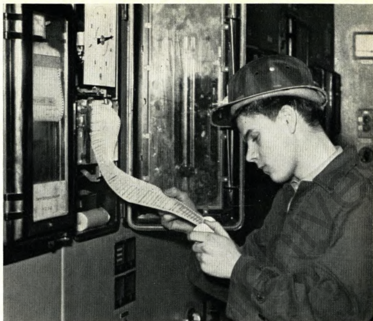
Im Hochofen-Meßhaus wechselt ein Lehrling die Papierrolle eines elektrischen Schreibgeräts aus.
