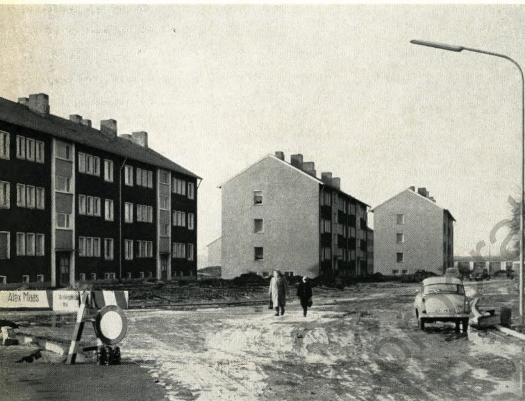
Die zuletzt bezogenen Miethäuser der Niederrheinischen Hütte in Rumeln, Am Lepelsbusch
