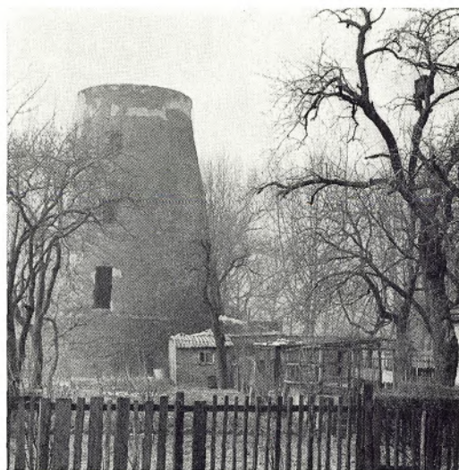
Unser Bild oben zeigt die Kiebitzmühle in ihrem heutigen Zustand — Unten: Bei den Ausgrabungen auf einem früheren fränkischen Friedhof im Bereich des Hafens Schwelgern im Jahre 1935 ging man vorsichtig an die Arbeit
