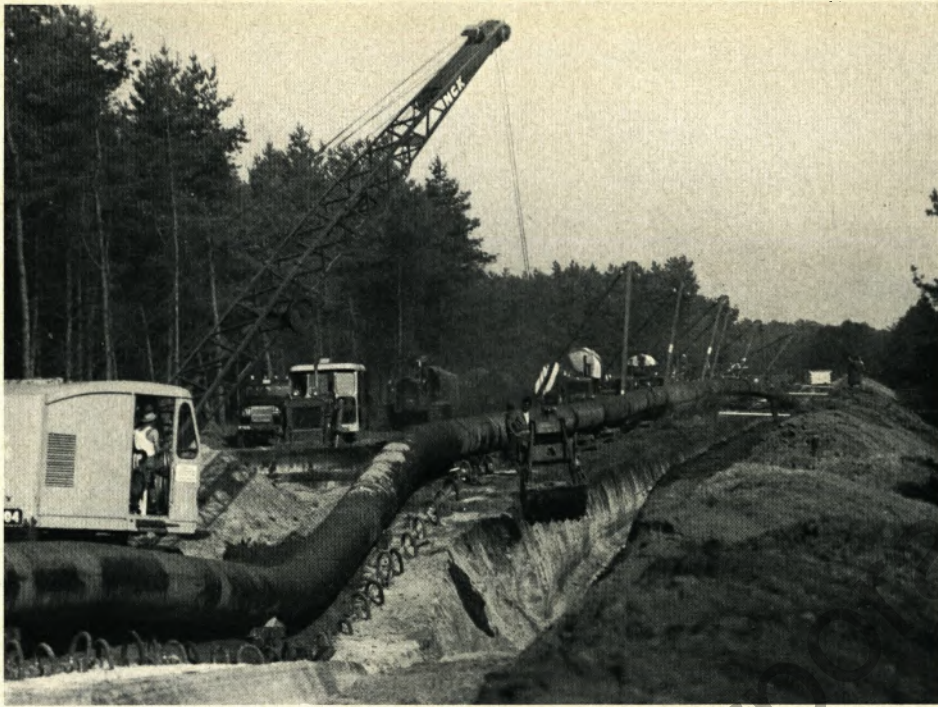
Mit modernsten Geräten werden die Gasleitungen verlegt, ähnlich wie unsere Leser es bereits aus Reportagen vom Bau der Ölleitungen her kennen. Unser Bild zeigt das Verlegen eines Teils einer Ringleitung in den Niederlanden.
