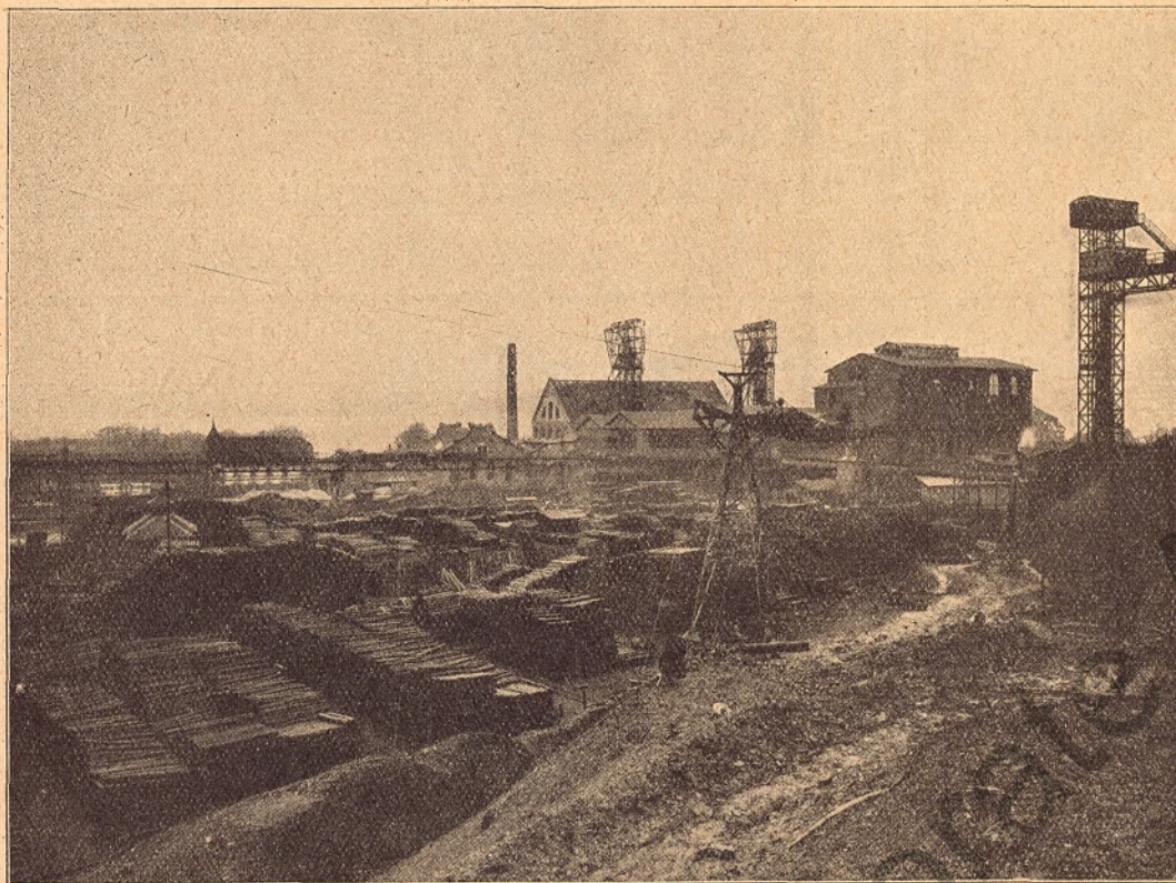
Schachtanlage Rheinelbe I u. II (von Osten)
