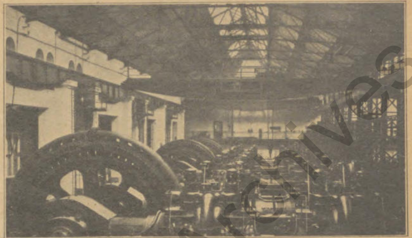
Gasdynamomaschinen, Gaszentrale.
