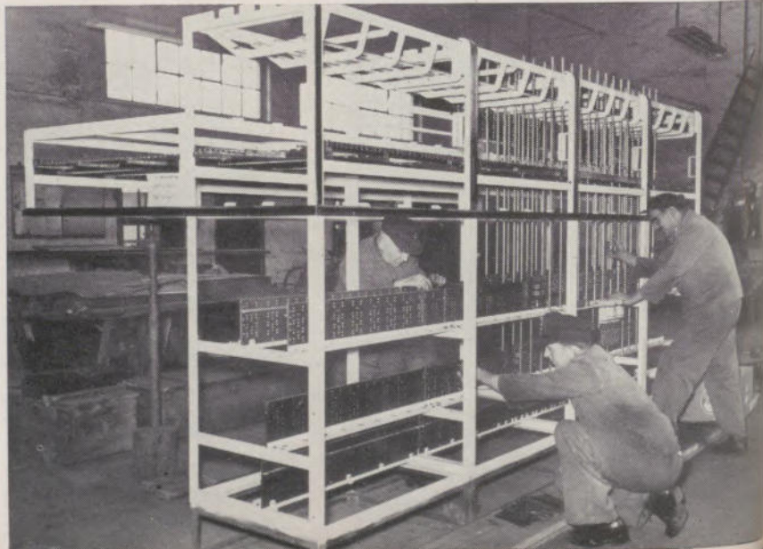
Abb. 6: Montage eines elektrischen Stellwerkapparates
