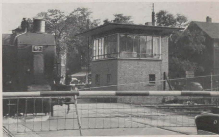
Abb. 3: Bahnübergang Weseler Straße in Marxloh
