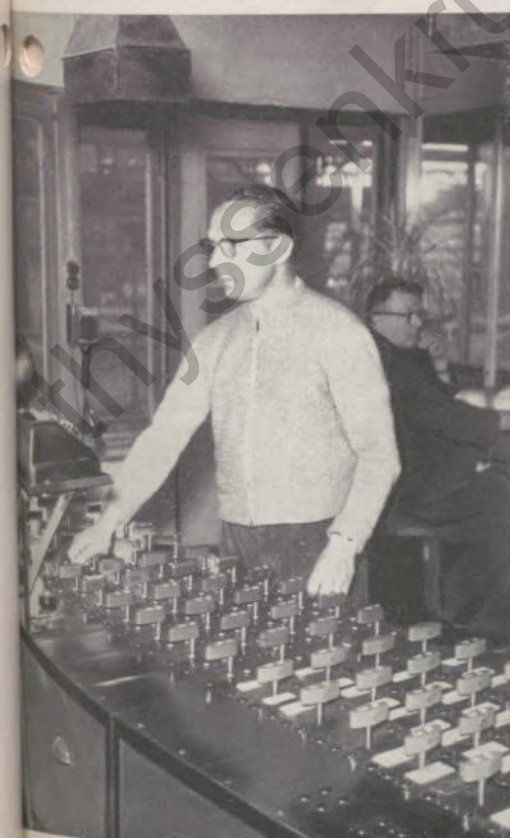
Abb. 2: Elektrisches Vierreihen-Stellwerk
