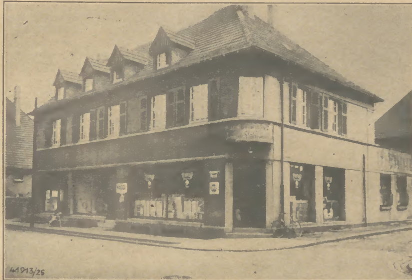
Konsumanstalt der Vereinigte Stahlwerke A.-G., Dortmund-Mengede, Ammerstraße 33
