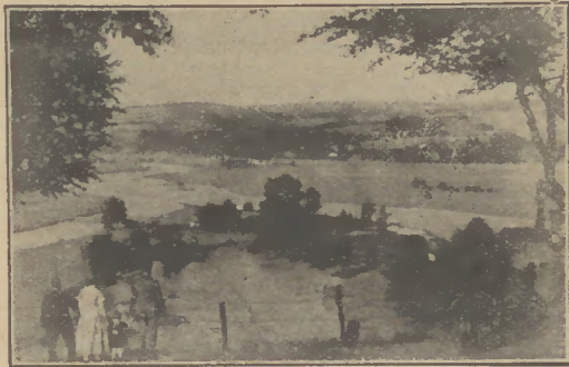
Blick in das Ruhrtal bei Blanksenstein. Links die Schleuse, rechts im Hintergrunde Haus Kemnade.
