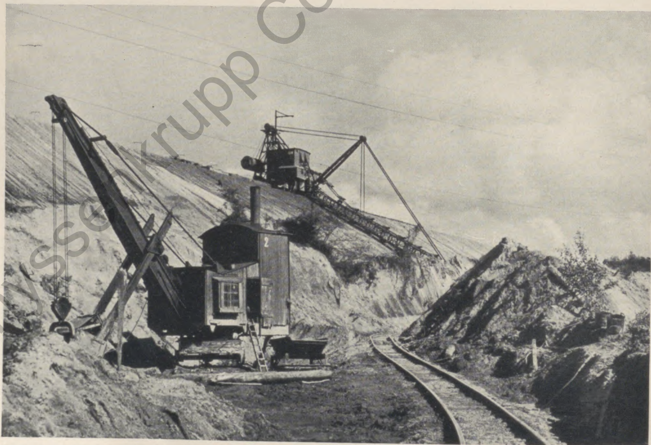
Bernsteinbergwerk Palmnicken; Bagger räumen die 40 m dicke Erdschicht über der „Blauen Erde“ weg; Bild: Dr. Sellbeck
