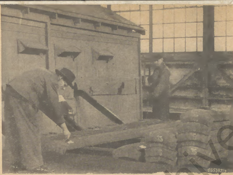
Werkfotos (2): Theo Mester Weichenschwellen werden von Spritzern gesäubert und die Nummern mit Farbe aufgetragen
