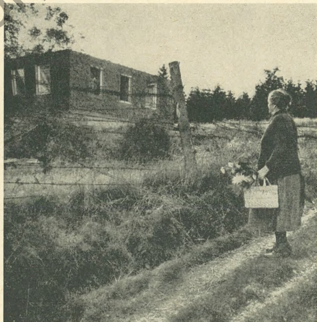
Im September 1958 wurde das Haus plötzlich abgerissen. Wehrlos und verzweifelt mußte die Eigentümerin zusehen, wie in wenigen Stunden alles das zerstört wurde, was sie sich einst mit ihrem Manne in vergangenen langen Jahren harter Arbeit geschaffen hatte
