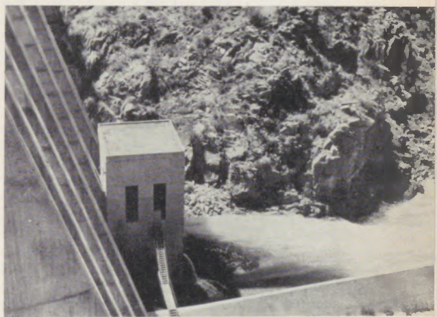
Das Nadelventil wird wieder geöffnet
