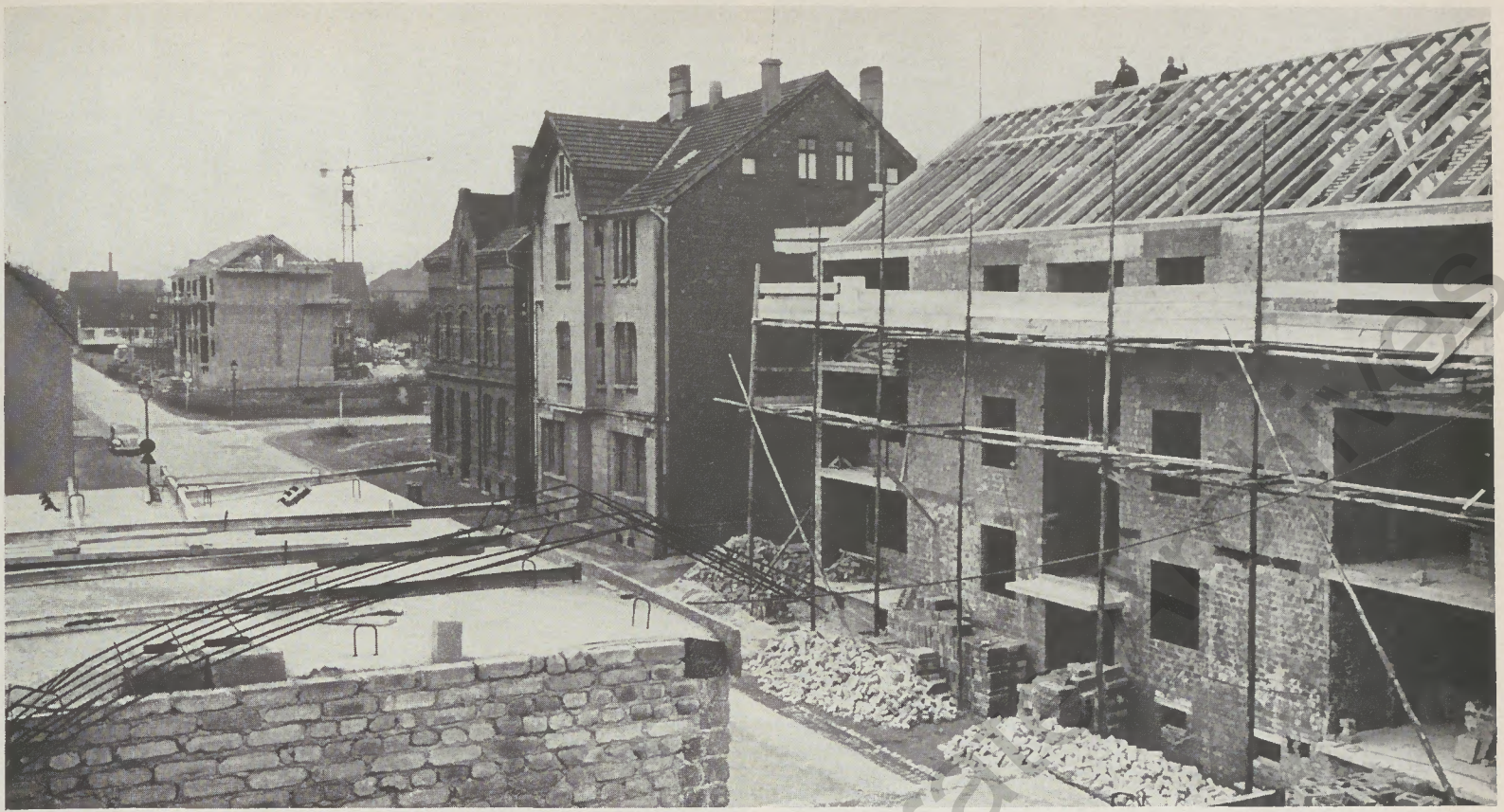
Ruhrstahl-Neubauten in der Westfeldstraße
