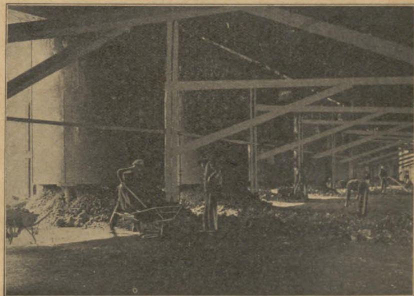
Teilsansicht der Röstanlage der Grube Bautenberg.
