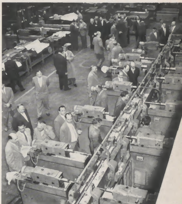
Automatische Bohroperationen: Vertreter verschiedener Firmen beobachten interessiert die Arbeitsweise der Transferstraße
