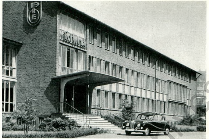
Neues Verwaltungs- gebäude 1956
