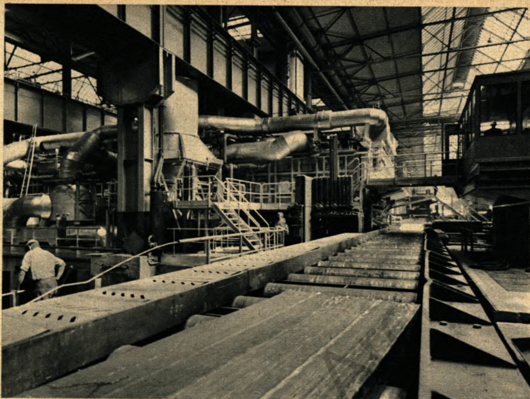
▲ Der 100-Tonnen-Stoßofen der Breitbandstraße wird mit Gichtgas von den Hochöfen geheizt. Rechts über dem Rollgang die Reglerbühne für den Ofen.
