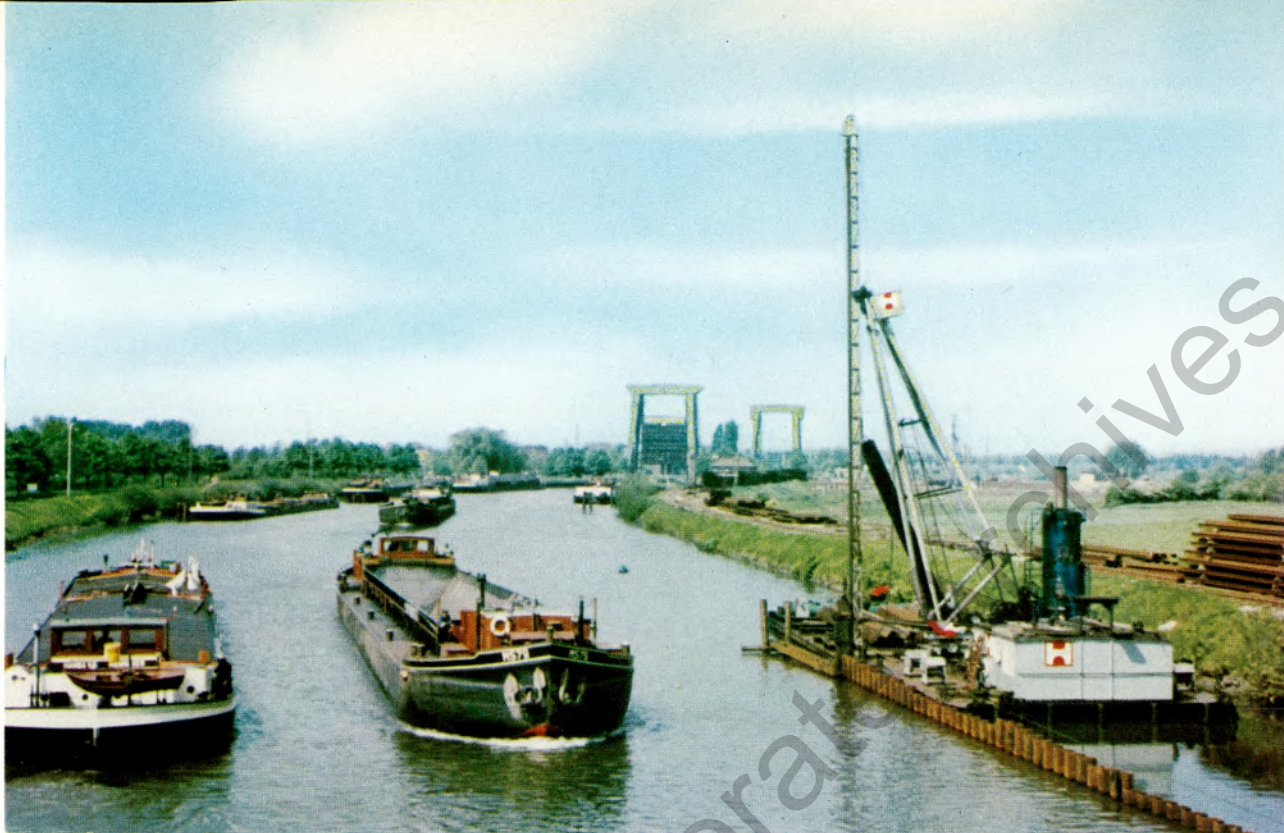
Abb. 8 Rammung einer Baugruben- umspundung aus Larssen- Stahlwänden im oberen Vorhafen der Schleusenstufe
