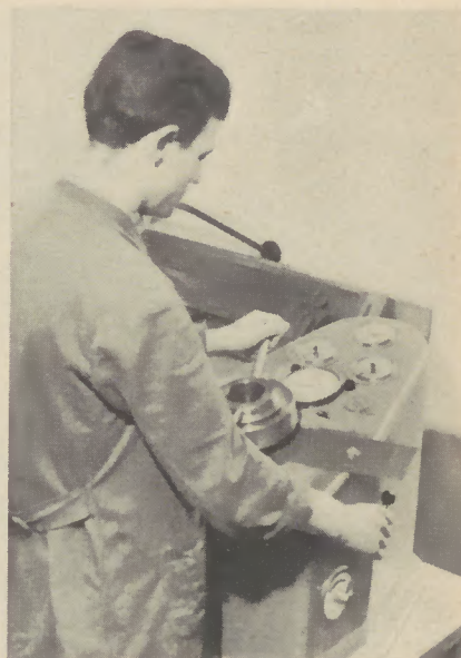
Werkstoffprüfer am Erichsen-Tiefungs-Gerät.
